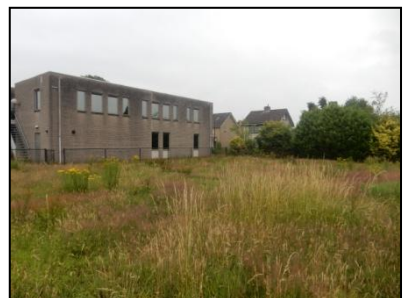
Figuur 5. Zuidzijde kantoorpand met verruigd weiland.
