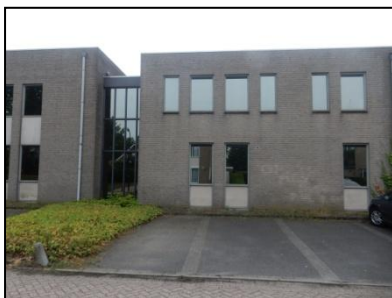
Figuur 3. Noordzijde kantoorpand.
